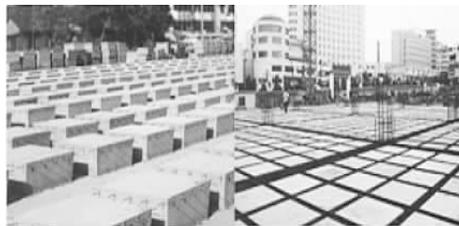
图 4 预制拼装箱体施工图片
